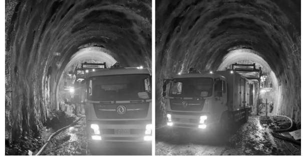
图2 现场混装炸药装药施工图
