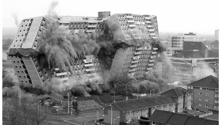
(b) 楼房二次折叠爆破 (英国, 2011 年) (b) Fold implosion of a building (The United Kingdom, 2011)
