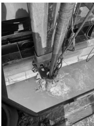
图 4 现场钻进试验 Fig. 4 Field drilling test
