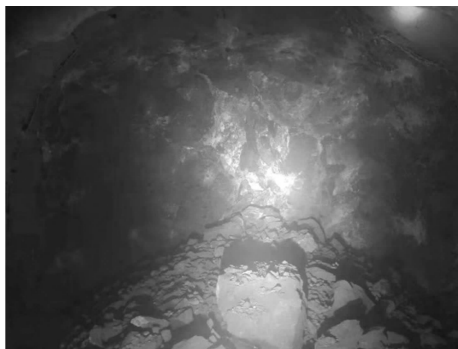
图8 巷道预裂-光面协同爆破后现场图
