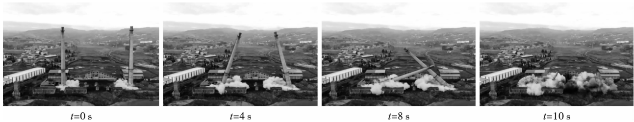
图7 爆破倒塌过程
