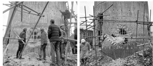
1# 烟囱试爆效果 1# chimney
