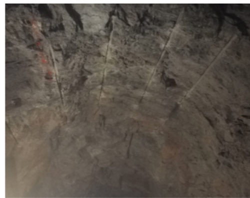
图11 改进炮孔布置方案后的爆破效果
