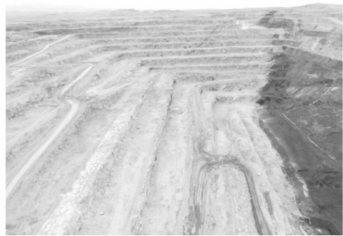
图2 台阶边坡现状图
