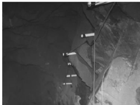
图 4 切缝药包布置图
