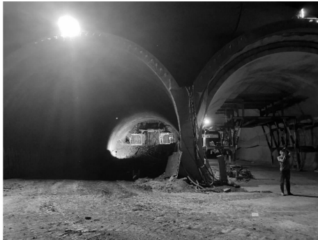
图1 无中墙连拱隧道
