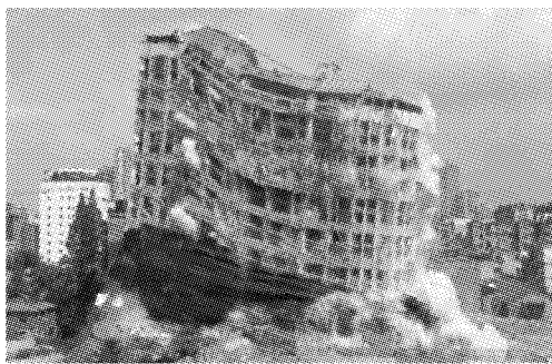
图2 武汉虹锦公寓爆破拆除
