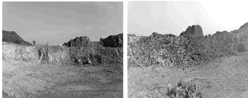
图3 +145平台4.5 m×4.0 m孔排距爆破前后现场图
