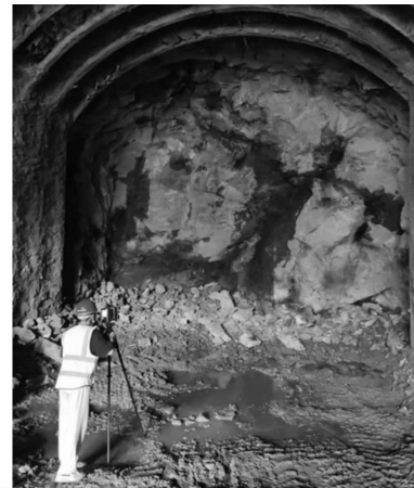
图3 隧洞轮廓激光扫描测量
