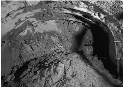
图 4 注浆孔施工图
