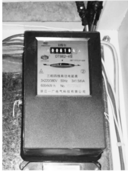
图4 采集的用户电表图像数据
