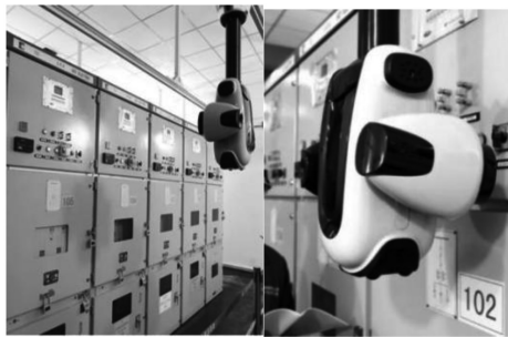
图2 智能配电网信息采集现场
