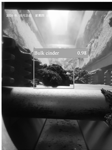
图 3 排渣机大渣检测图
