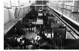
图 3 某智慧电厂的锅炉给水泵分布情况
