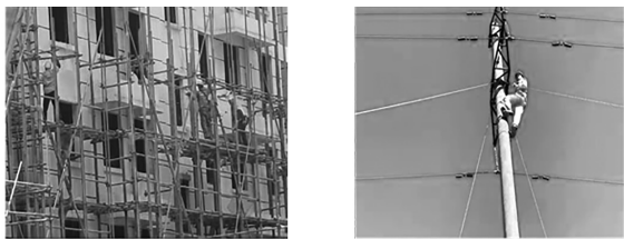
(a) 脚手架高空作业 (b) 电力维修高空作业
