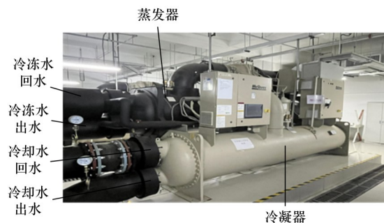
图7 地铁冷水机组示意图
