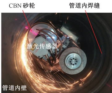
图 14 管内特种机器人磨削焊缝
