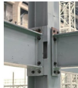
图 3 端板连接现场图
