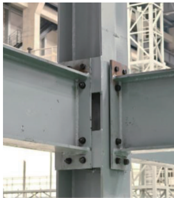
图5 端板连接现场图
