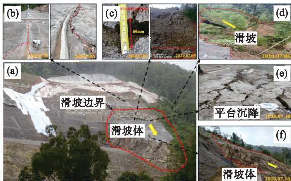
图 19 边坡变形破坏特征
