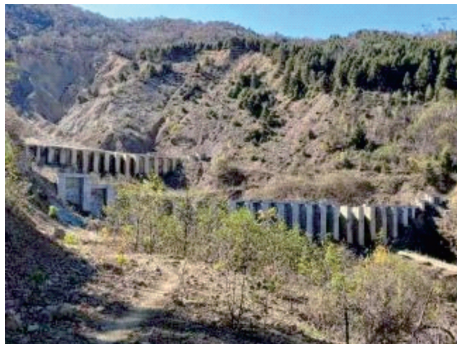
图 1 源头滑坡治理
