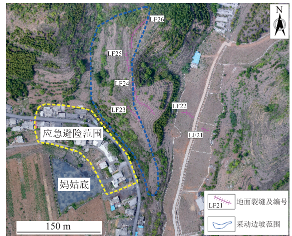
图1 妈姑底北侧边坡概貌
