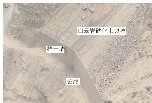
图1 白云岩砂化土边坡全貌
