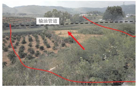
图 1 滑坡整体照片
