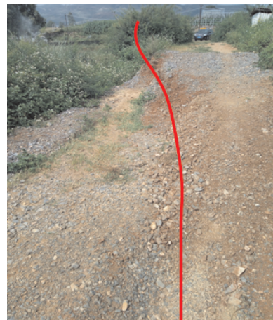
图 3 滑坡后缘裂缝
