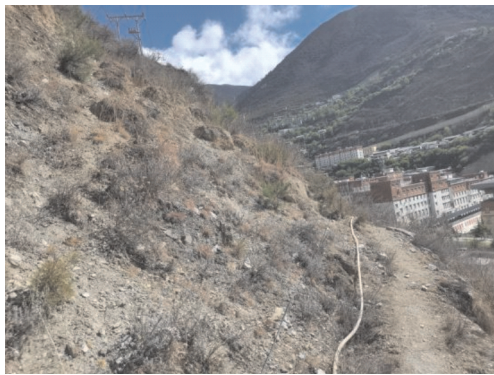
图4 滑坡中部小规模坍塌
