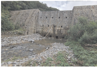
图6 L2拦渣坝运行良好(灾后)
