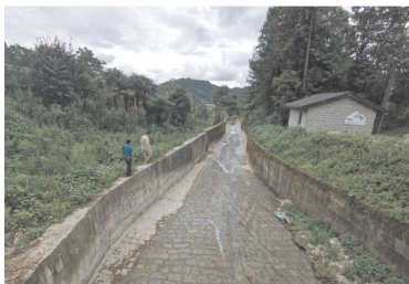
图7 下游排导槽运行良好(灾后)
