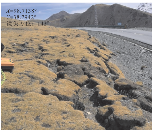
图5 省道 S204 旁冻融滑塌现象
