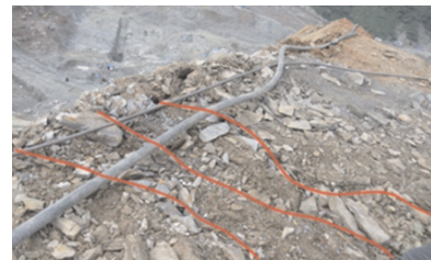
图 10 1 415 m 高程平台顺层裂缝
