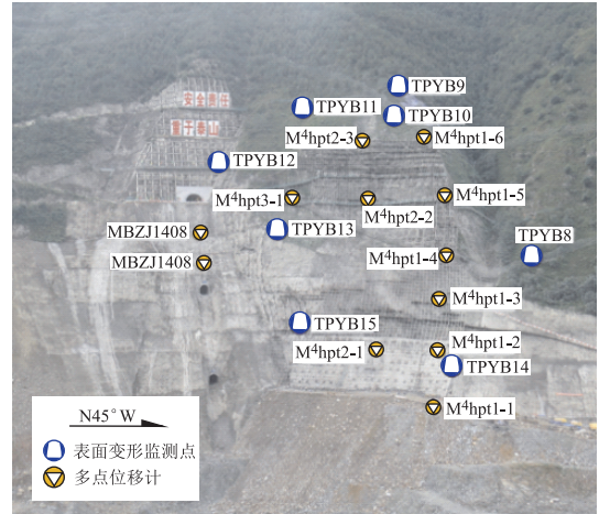
图 14 右坝肩边坡监测点布置平面图
