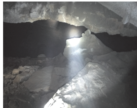
图6 掌子面揭露大型无充填型溶洞
