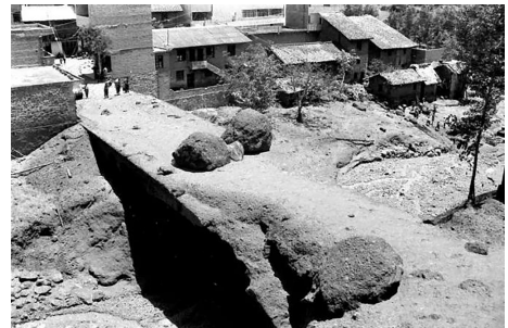
图 2 1997 年 5 月 8 日泥石流掩埋桥梁(调查收集)
