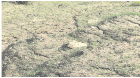
图 5 泥石流下游堆积区掩埋梯田
