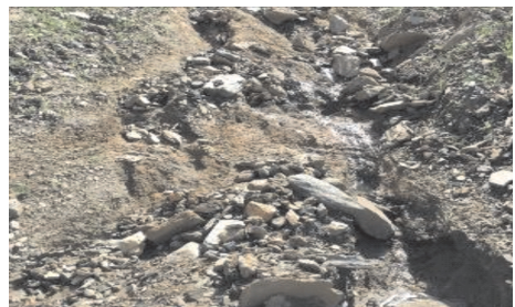
图4 流通区梯田被侵蚀
