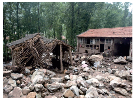
图 2 泥石流造成房屋损坏(镜向西北)
