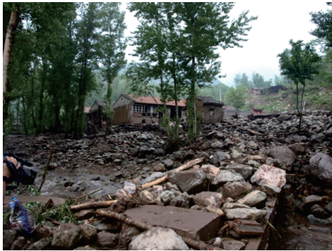
图4 泥石流造成房屋桥梁损坏(镜向东北)
