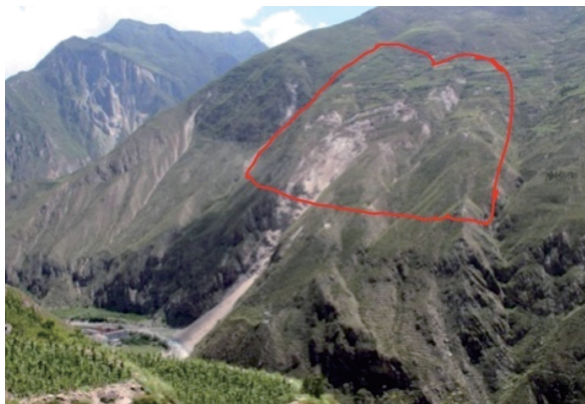
(a) 滑坡全貌
