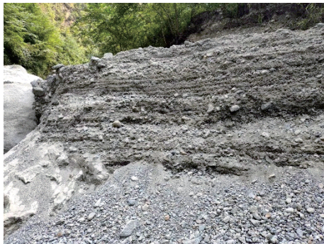
图 6 回龙沟沟道多次泥石流堆积
