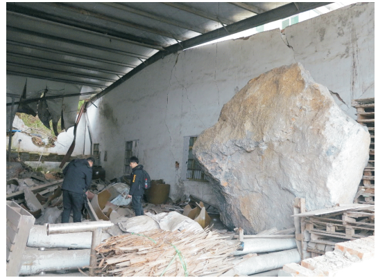
图 1 坡脚建筑物破坏
