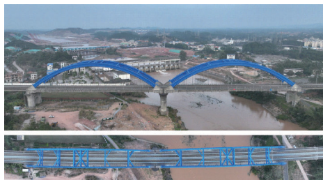
图 3 邕北线钦江双线特大桥梁防腐涂装维护竣工图
