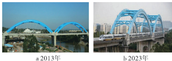
图 1 邕北铁路钦江双线特大桥景观变化
