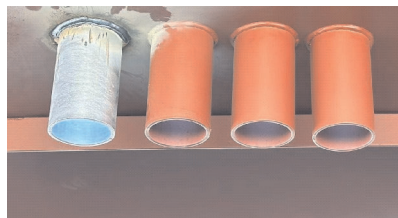
图4 喷砂后再进行焊接的穿舱管
