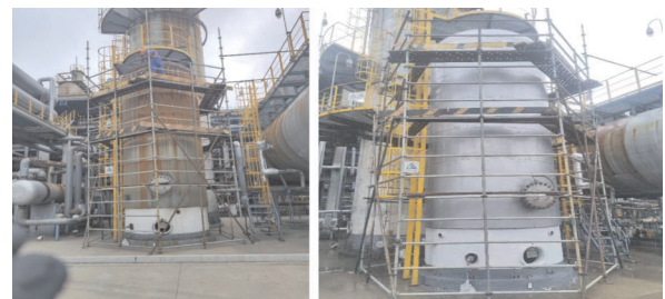
图 2 空气压缩罐未涂装及涂装后的效果
