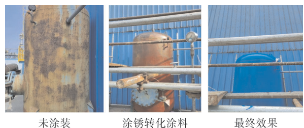
图 3 过滤器罐未涂装及涂装后的效果
