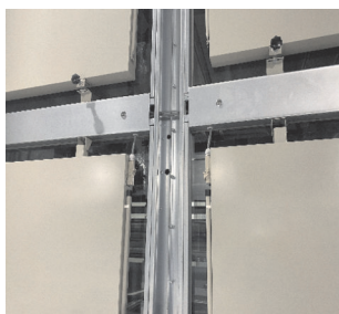
图 2 模段扣板连接样式
