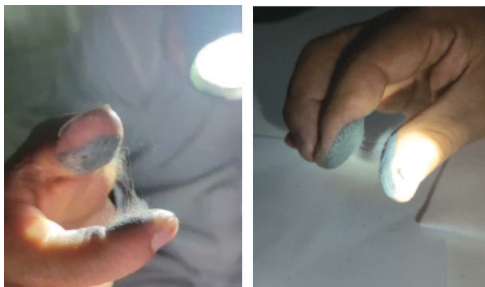
图4 喷漆室壁板积漆及原漆拉丝状态
