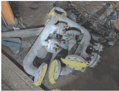
图3 材料运输中不加防护导致的涂层破损
