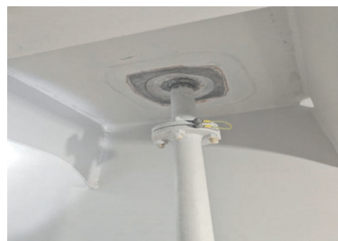
图4 因材料供应不及时导致的后期补焊
