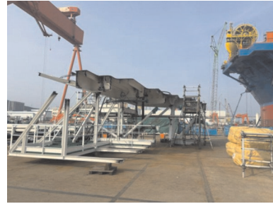
图5 吊装精度控制差导致的飞机甲板切割
