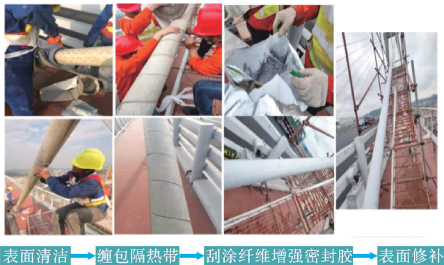
图3 黄埔大桥斜拉索防火施工
