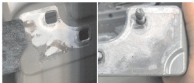
图 1 右 B 柱下铰链电泳后拆解情况
