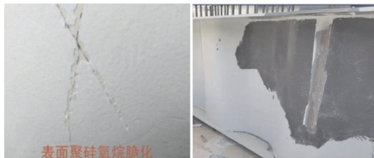
图 1 聚硅氧烷脆化及配套聚硅氧烷面漆脱落
