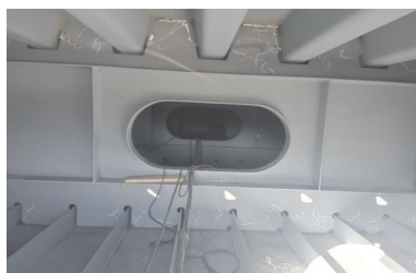
图1 某项目钢箱梁内表面涂装冷涂锌
