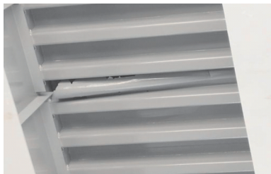
图5 某项目正交异性桥面沥青铺装后
