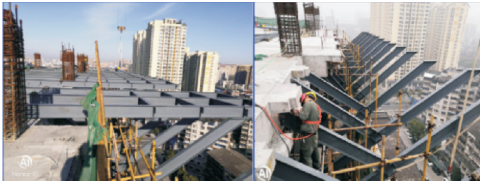
图 13 13层钢平台安装实景
