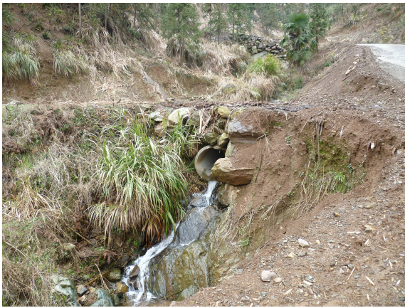
图4 研究区泥石流冲沟内淤积严重
